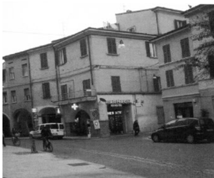
L'aspetto attuale dell'ex Albergo del Commercio in corso Diaz n.79.
